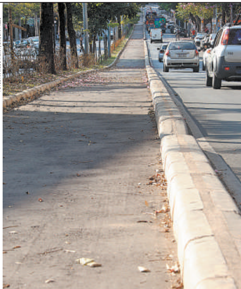
NA PARTE FINAL DA AVENIDA AFONSO PENA, A CICLOVIA JÁ ESTÁ SEPARADA FISICAMENTE DA PISTA DE ROLAMENTO DOS VEÍCULOS AUTOMOTORES
